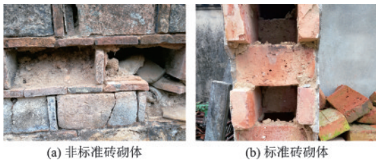
图2 砌体房屋砌体墙空心砌筑方式
