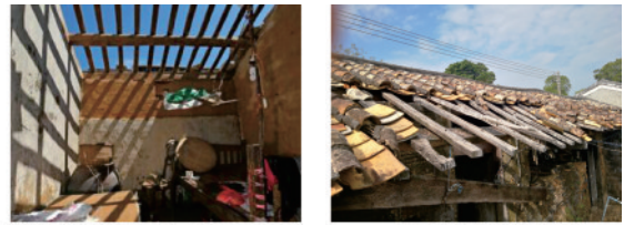
(a) 瓦片全部刮落(来源: blog.sina.com.cn) (b) 瓦片部分刮落
